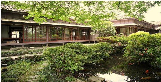
(Kronprinzhütte Bild: http://www.taiwanxing.com.tw/ )
