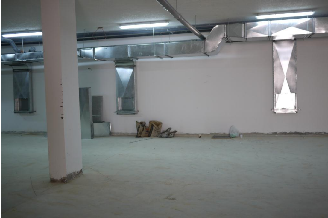
館舍區停車場 duct termination 施作完成
