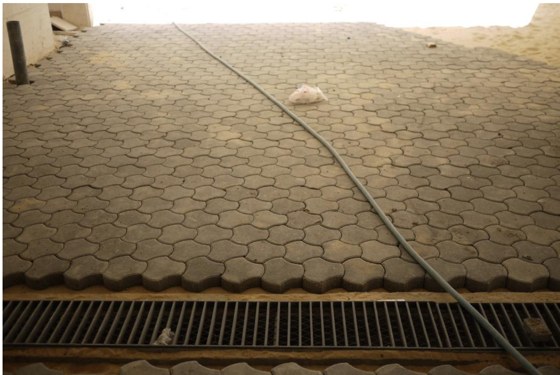
館舍區停車場 interlock 石磚鋪設完成
