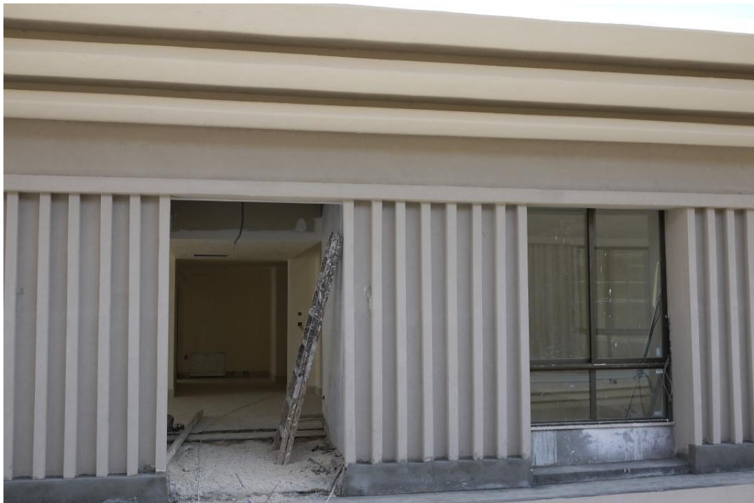
宿舍區外牆直柱及懸臂油漆粉刷
