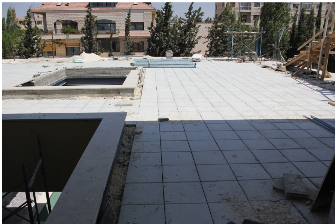
館舍區 2 樓(實際第 4 樓)平台石板鋪設工程
