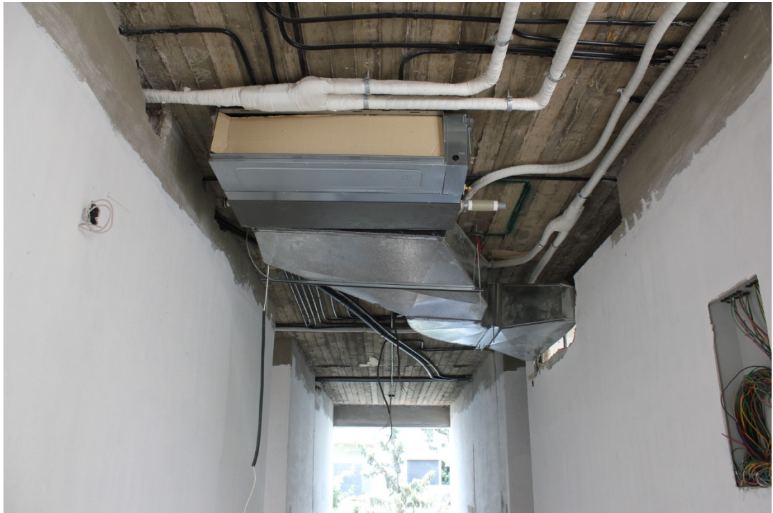
宿舍區 2 樓(實際第 3 樓)空調主機及 duct 架設工程 1
