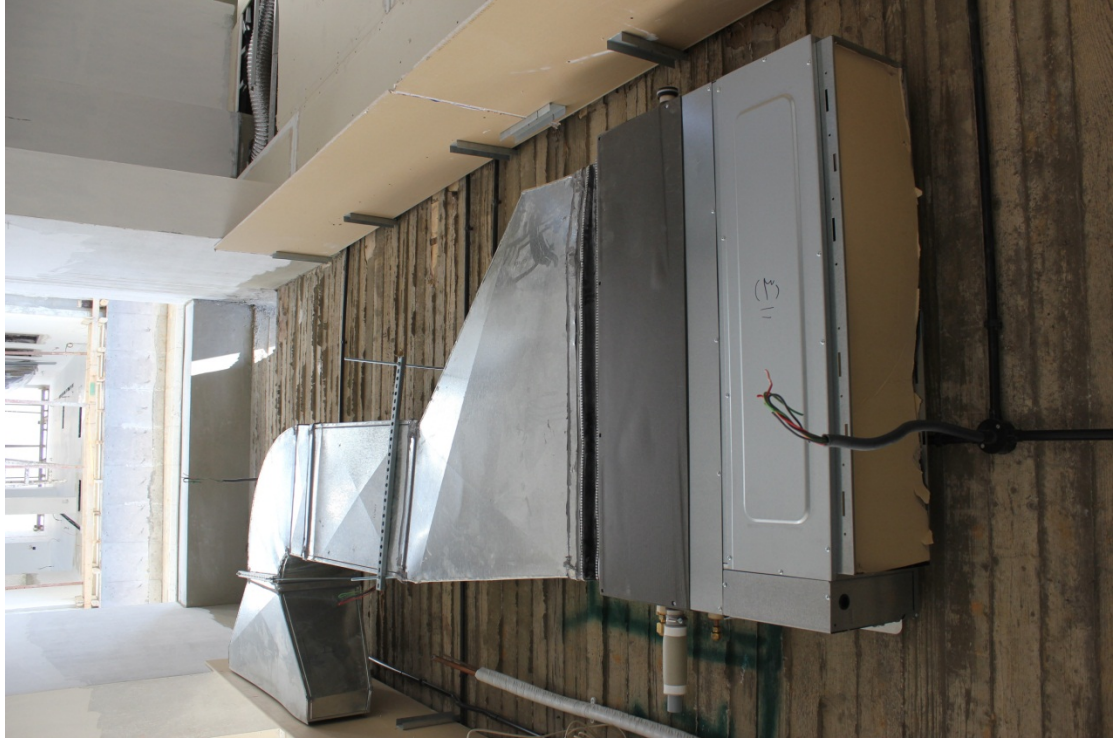
宿舍區 2 樓(實際第 3 樓)空調主機及 duct 架設工程
