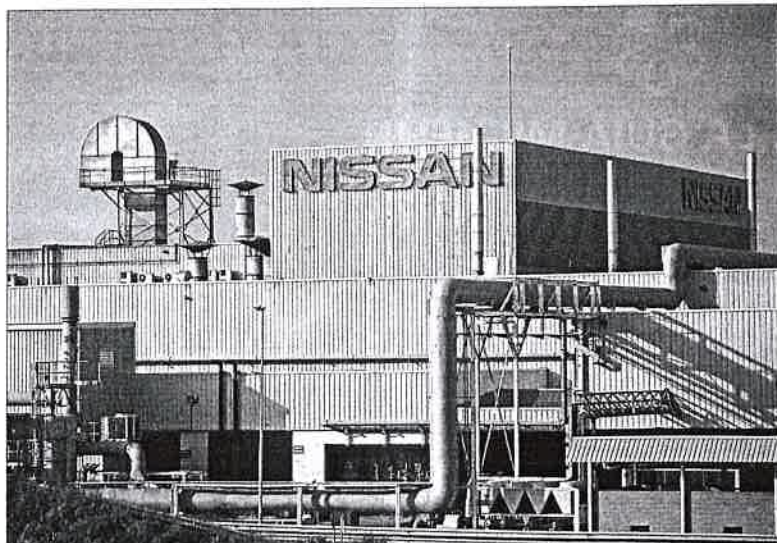
Las instalaciones de Nissan en la Zona Franca de Barcelona. / ALBERT GARCIA
